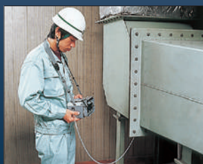
ダクト内の静圧測定に
