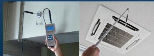
空調機器の能力試験・保守点検
