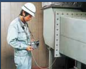
ダクト内の風速・静圧測定に
