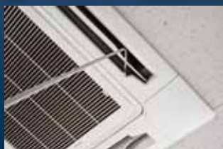
空調機器の能力試験・保守点検
